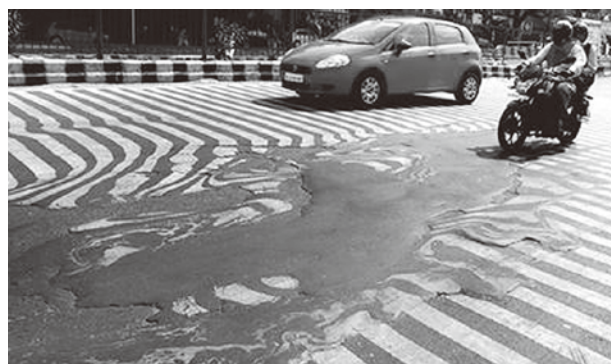
写真3 高温による道路の横断歩道の変形（インド） 【 http://news.qq.com/a/20150528/003874.htm （2015）】
