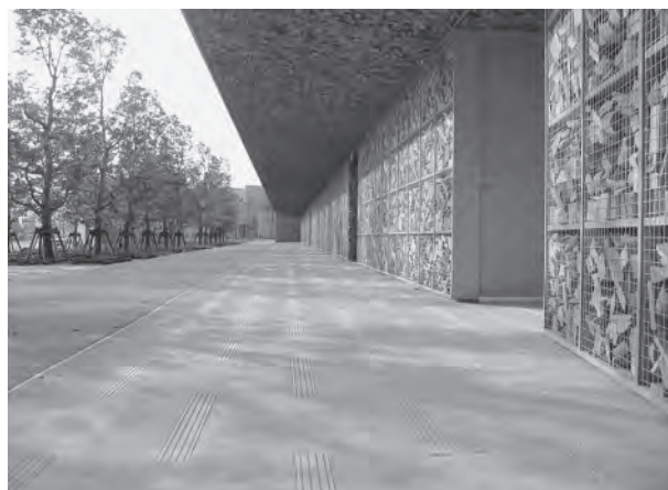
図1 土舗装の施工例
