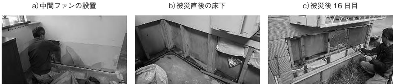
図10 壁内部空間の復旧(被災後16~23日目)
