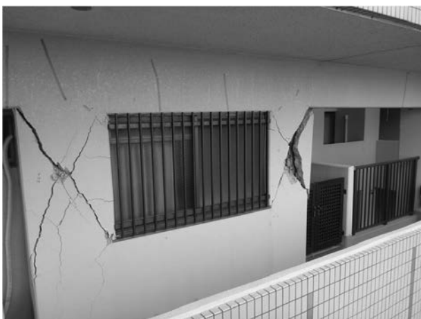
写真1 建築基準法上は問題ないが、地震後に継続使用が困難になった被害事例
